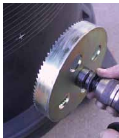
Bohren des Loches für die Einlaufdichtungen
