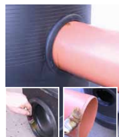
Anschluss des Schutzrohrs aus PVC
