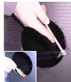
Einsetzen der Einlaufdichtungen
