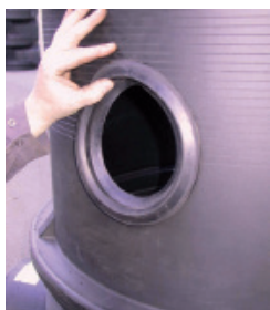
Einbau der Eingangsdichtung
