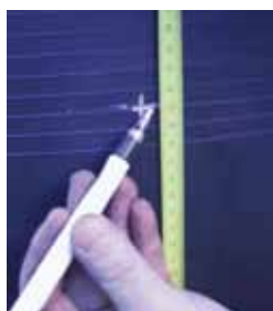
Določitev središčne višine dodatnega priključka
