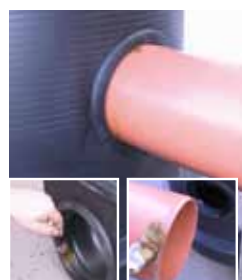
Priključitev PVC zaščitne cevi
