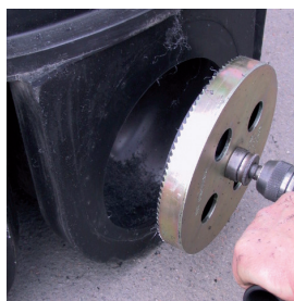
Vrtanje vstopne izvrtine z ustreznim kronskim sve-drom, adapterjem in ročnim vrtalnim strojem
