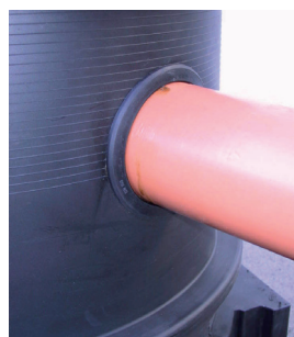
Priključitev PVC cevi
