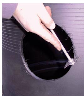
Čiščenje in mazanje roba
