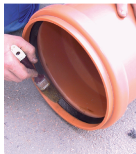
... ter PVC cevi in tesnila
