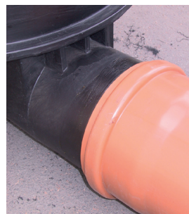
Priključitev PVC cevi
