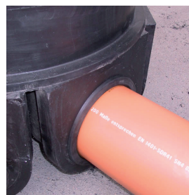
Priključitev cevi na jašek
