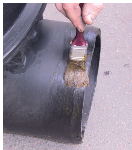
Mazanje roba stopničastega nastavka...
