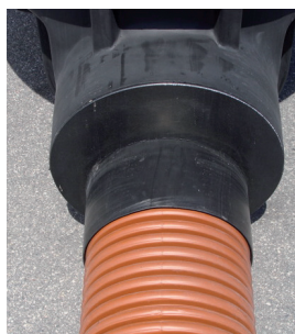
S primerno mastjo se namaže notranja stran priključka in tesnilo za cevi, cev se vstavi v jašek
