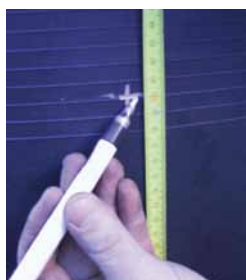
Določitev središčne višine dodatnega priključka
