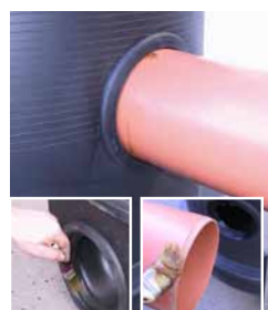
Priključitev PVC zaščitne cevi
